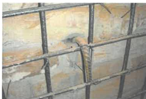
PRINCIPIU PRINDERE CONECTORI ÎN STRUCTURA EXISTENTĂ SCARA 1:50
